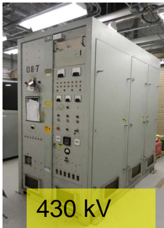
50 MW klystron
